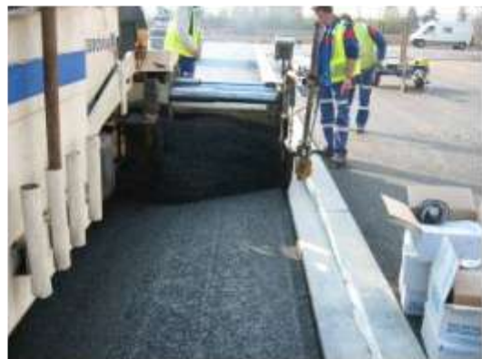
Enrobé / Caniveau en Béton
