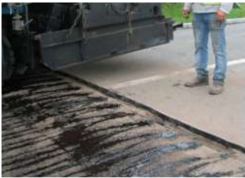
Démarrage de finisseur
