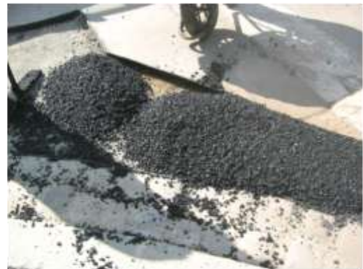
Pavé + enrobé ancien / Enrobé neuf
