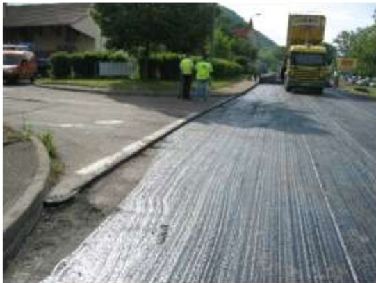
Enrobé ancien / Enrobé neuf
